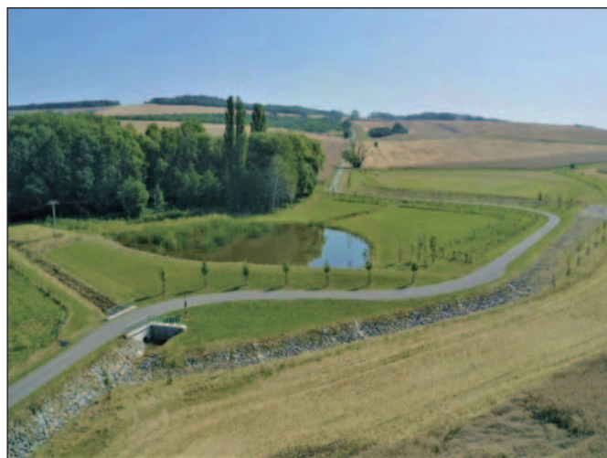
Němčany, pohled Dron
